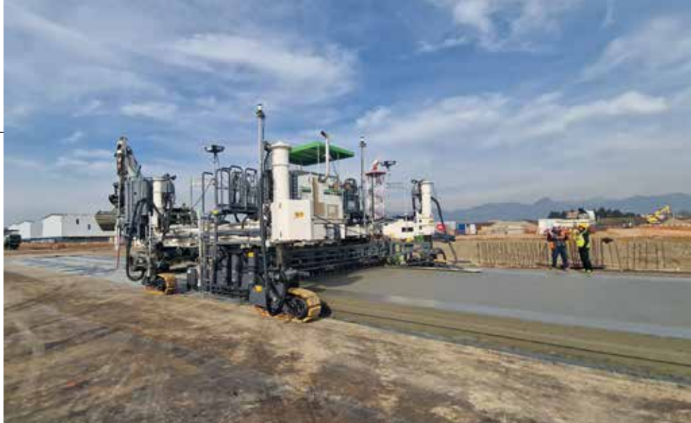
2. Finitrice a casseforme scorrevoli Wirtgen SP64i con Sistema 3D UTS Trimble PCS900
